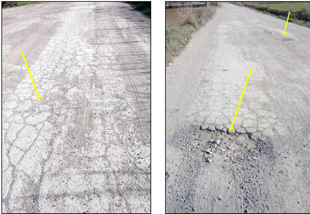
Εικ.2,3: Χαρακτηριστικές εικόνες της ολικής αστοχίας του υφιστάμενου ασφαλτοτάπητα της αγροτικής οδού.
